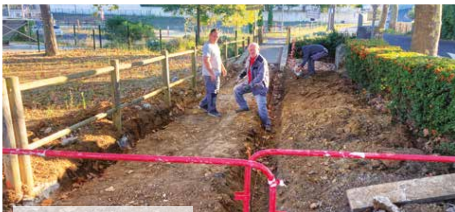
Passage en béton en remplacement d'un chemin de terre à l'aire de jeux route de Nizas.
